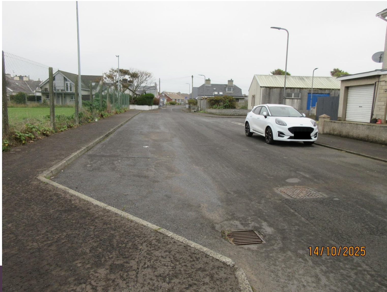
Layby on York Avenue
